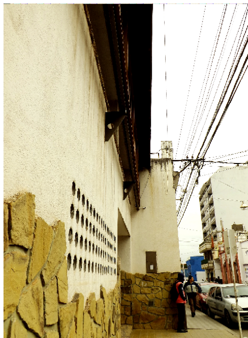
Fig. 5. Espacio de acceso sobre calle Caseros. Fuente: fotografía Ana Paula Díaz, 2016.
